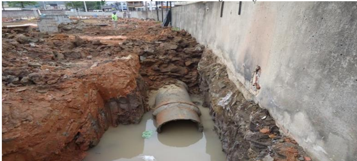
Figura 2 - Execução da rede de Drenagem - Afogada
