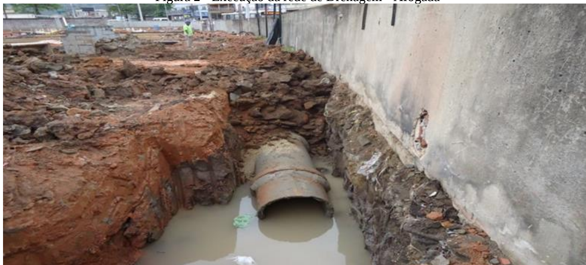
Figura 2 - Execução da rede de Drenagem - Afogada
